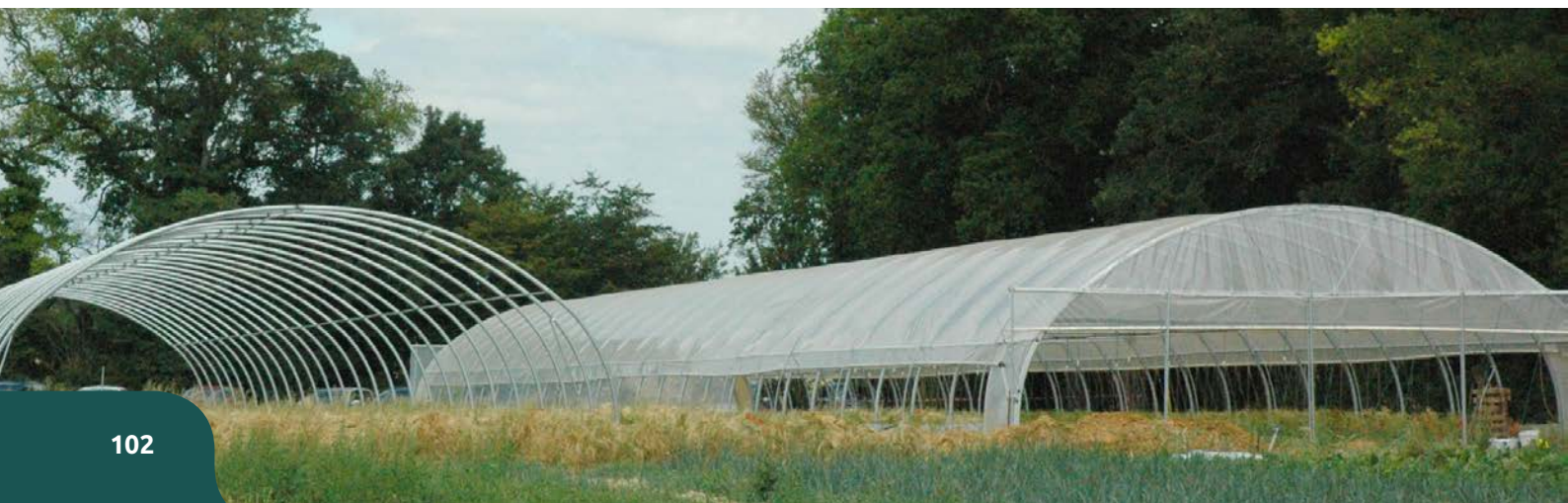
Montage des serres en juin 2017
