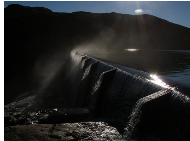
Vandkraftværk hydro installation. Capacity: 3 \times 15 MW.
