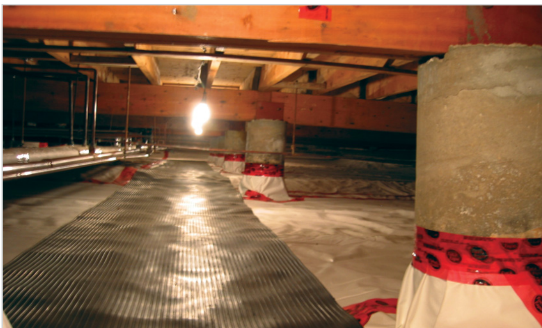
Figure 2 Le vide sanitaire après sa remise en état
