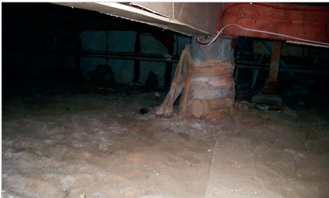
Figure 1 Le vide sanitaire avant sa remise en état
