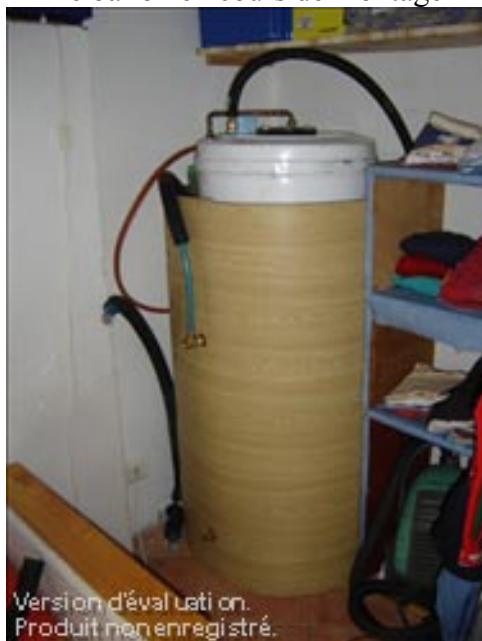
Le ballon en cours de montage
