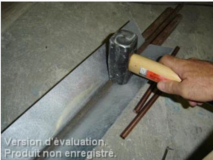
Incrustation du tube cuivre plus bas que les bords du rail
