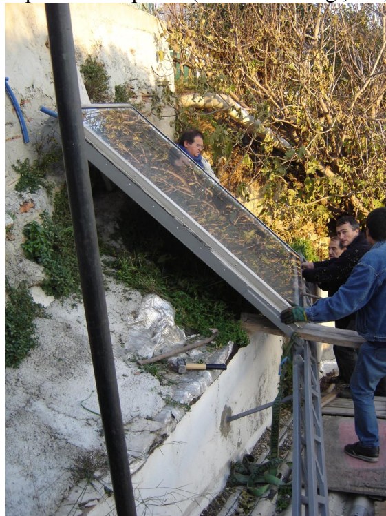
Mise en place des capteurs (environ 150 Kg ; dur,dur...)
