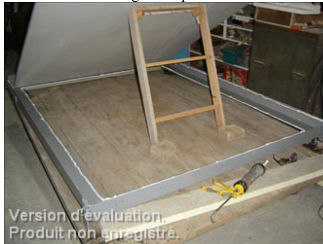
Montages des panneaux
