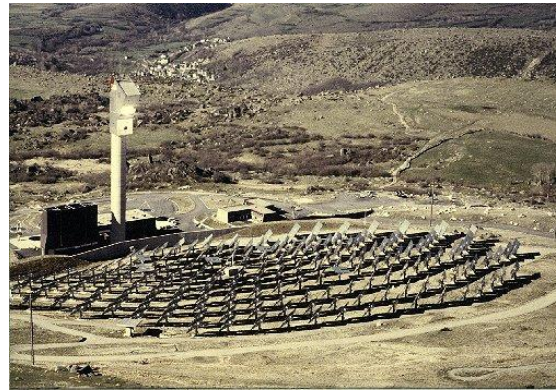
Figure 8 : Photo de la centrale Thémis.
