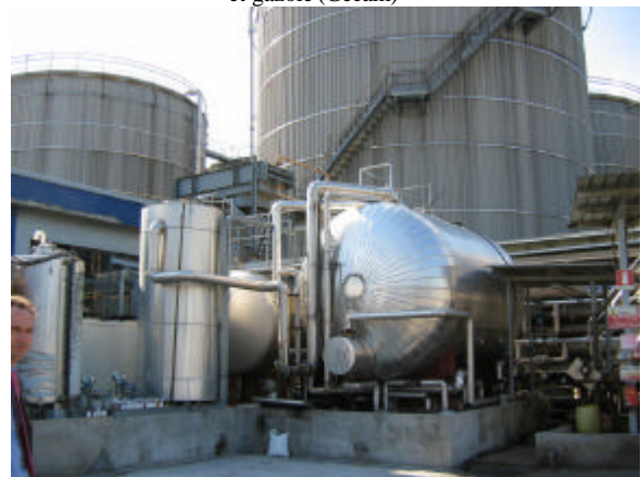
Process de fabrication de l'émulsion : pompe pour mélanger eau et gazole (Gecam)
