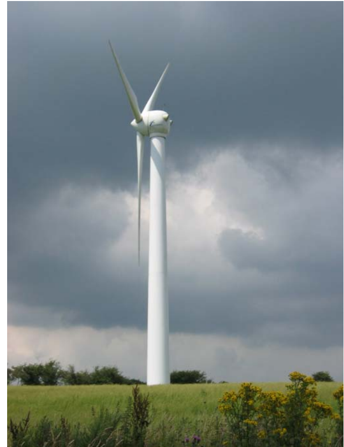
Eolienne Jeumont J48, ferme de Plougras (Bretagne)
