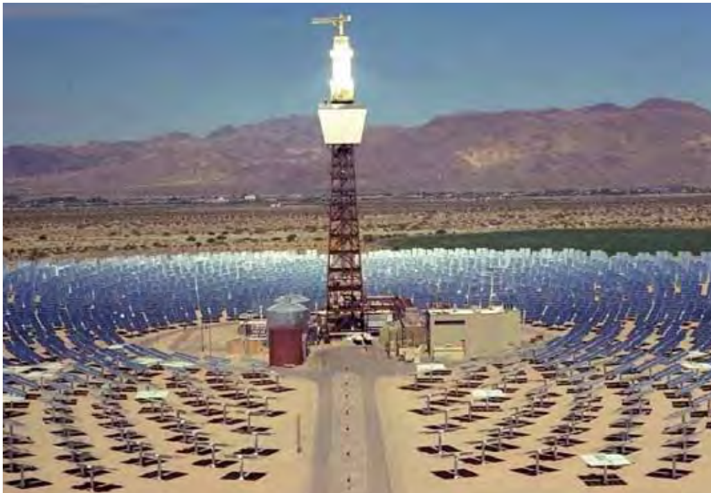
Ilustración 1.15. Planta de receptor central Solar Two, en Barstow (Estados Unidos).
