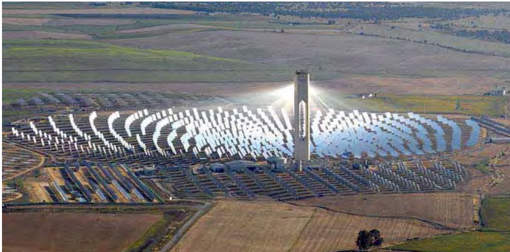
Ilustración 1.4. La planta solar termoelectrica PS 10 en funcionamiento.
