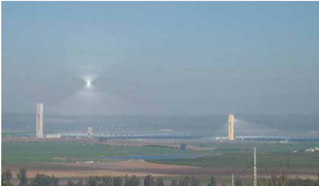
Ilustración 1.3. Plantas solares termoeléctricas PS10 y PS20 en Sanlúcar la Mayor (Sevilla).
