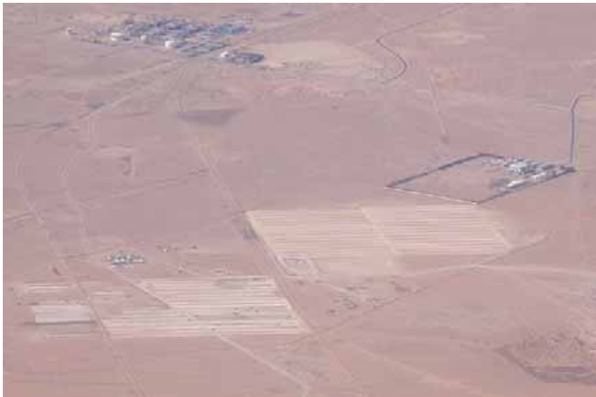
Ilustración 4.3. Estado de las obras de la planta de Argelia.
