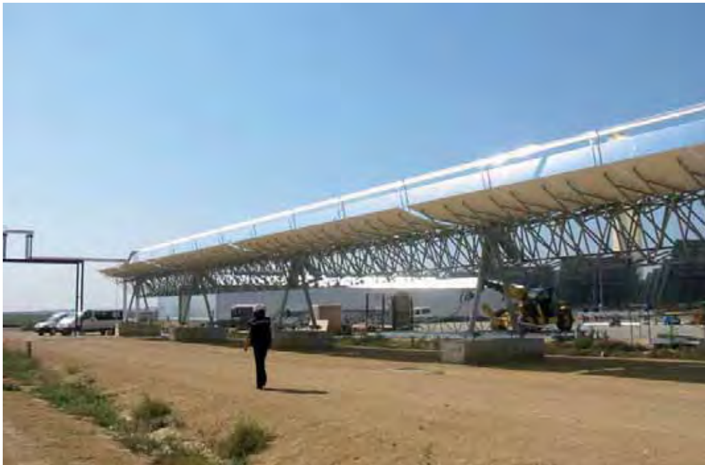
Ilustración 1.14. Canal parabólico en operación.
