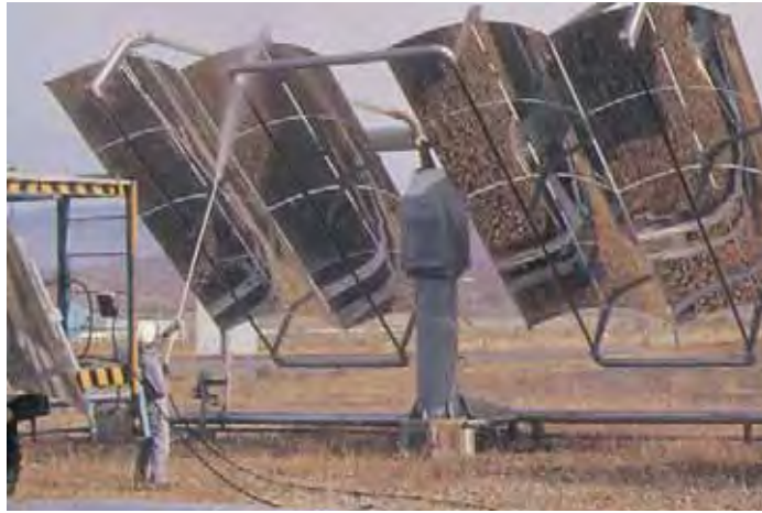
Ilustración 1.13. Canal parabólico con seguimiento en dos ejes Helioman en proceso de limpieza.
