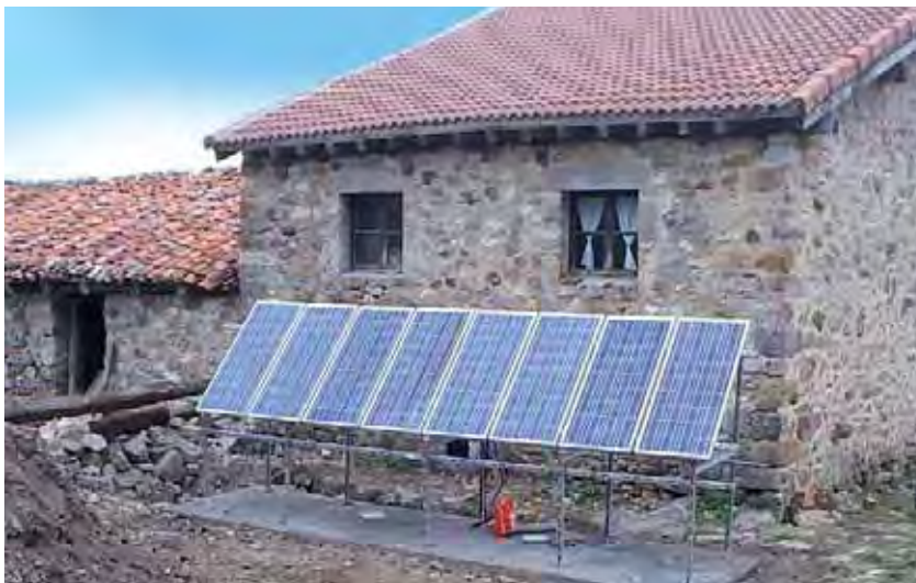
Ilustración 1.1. Instalación fotovoltaica aislada.
