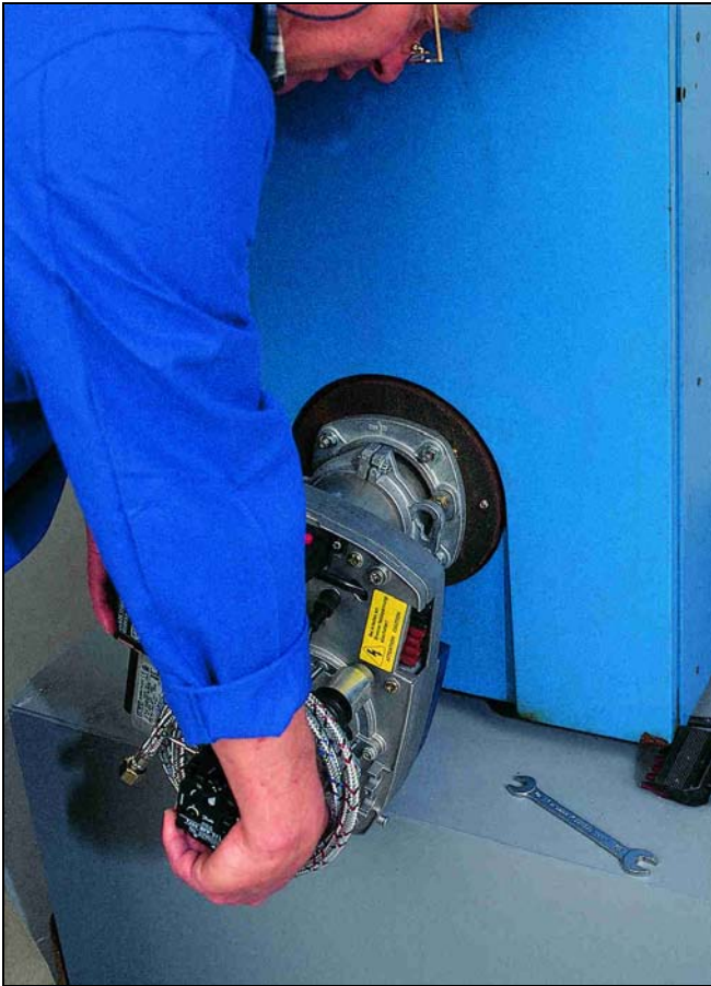
Fig. 9 : Montage brûleur – chaudière III
