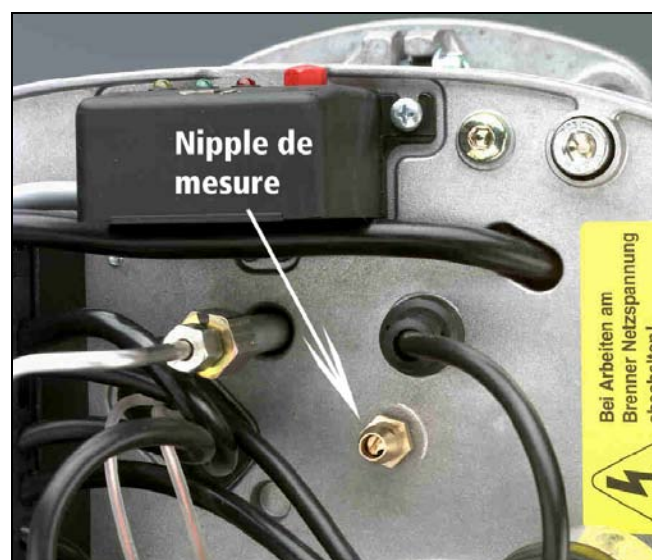
Fig. 17 : Nippes pour mesurer la pression de soufflage
