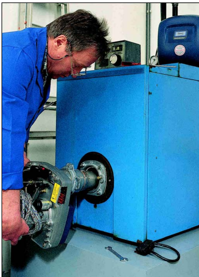
Fig. 8 : Montage brûleur – chaudière II
