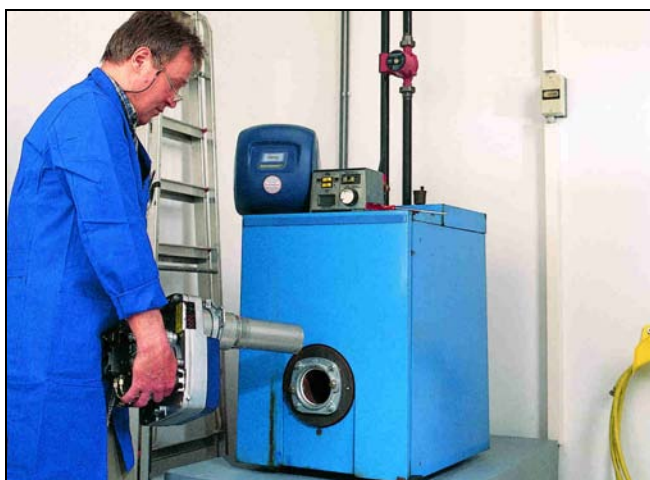
Fig. 7 : Montage brûleur – chaudière I
