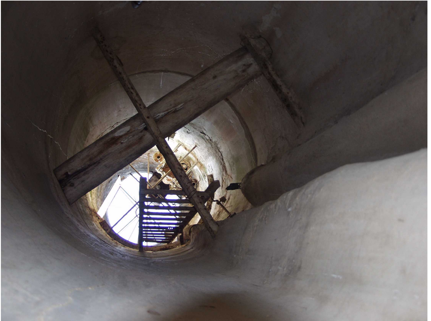
La tour de Pont-Roux (intérieur R.d.C.)
