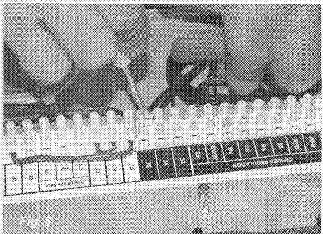
Fixer le bornier par ses 2 clips en s'aidant d'une pointe de tournevis sur le tableau électrique (Fig. 6).
