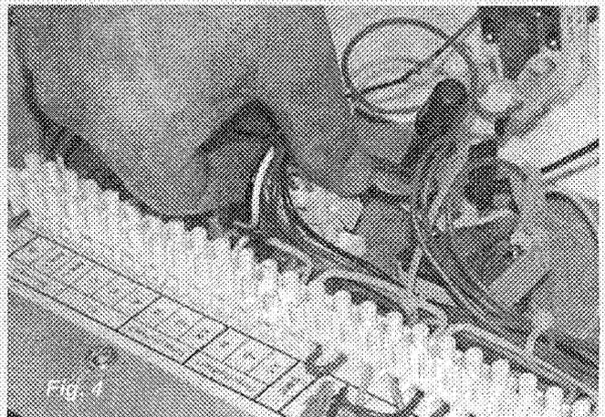
Enlever le connecteur en place dans le tableau de la chaudière (Fig. 4).
