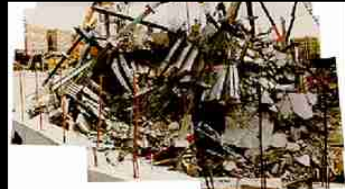
Un effondrement (Tremblement de terre) ?
