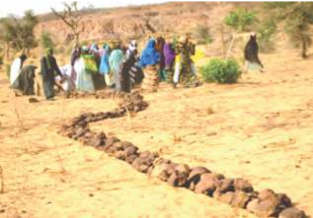
Planche 2: Construction de cordons pierreux
